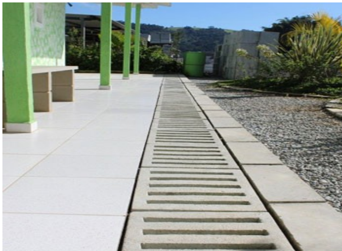
Foto ilustrativa, grelha em concreto.
